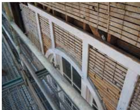
▲階段大窓周囲の木摺（きざり）
