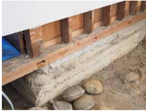
▲外壁下部の布基礎
