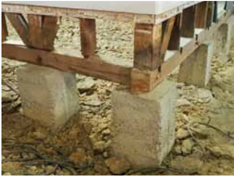
▲間仕切壁下部の独立基礎
