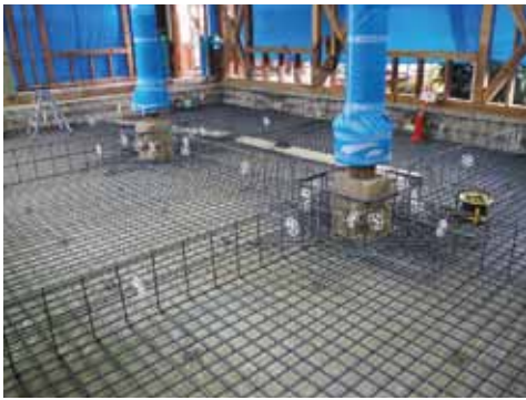
▲ベタ基礎の配筋
