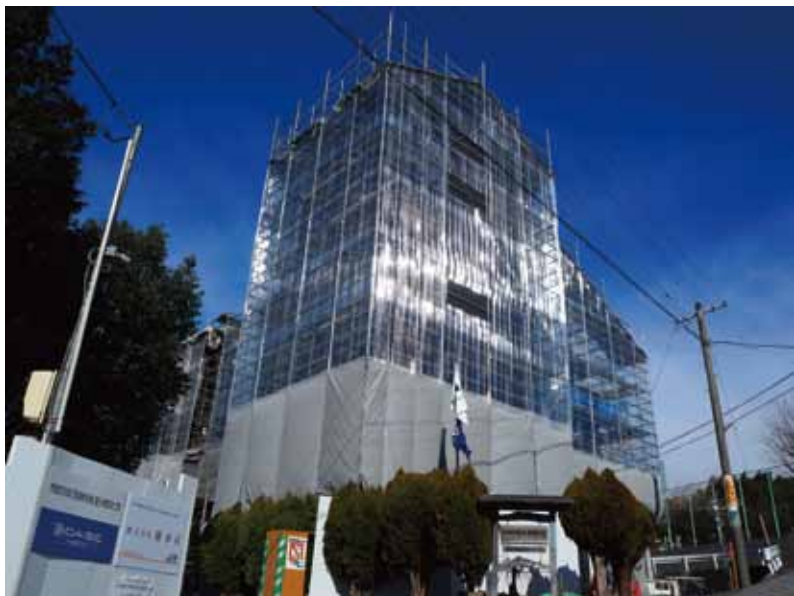
▲全体を覆われて工事が進む旧四郷村役場 (四郷郷土資料館)
