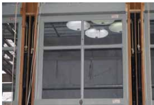
▲枠の中、バランスをとる重り
