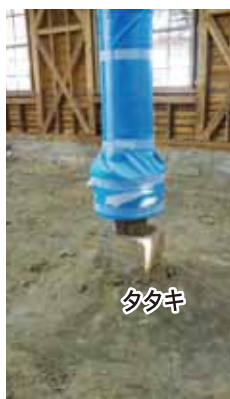
礎石 コンクリート
