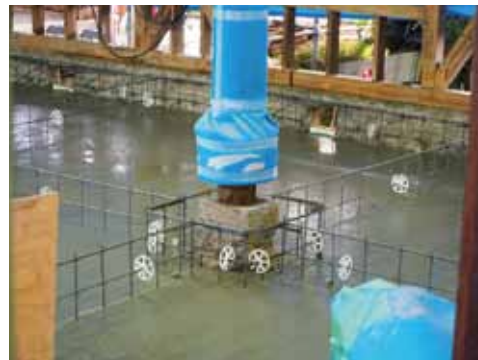
▲コンクリート打設
