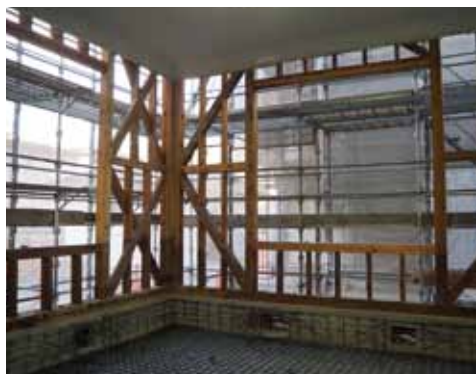
▲外壁解体の状況
