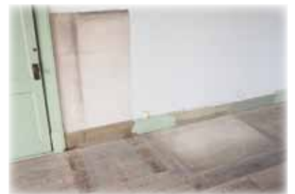
▲着工前のモルタル床
